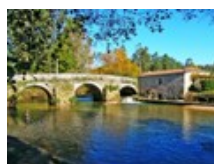
84 Moinho de Estorãos Ponte de Lima 1 Apx2; 2 Apx4
