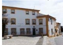
22 Casa do Largo Crato 4D; 3 Tw; P; PV
