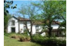
26 Casa do Outeiro Ponte de Lima 3 Tw; P
